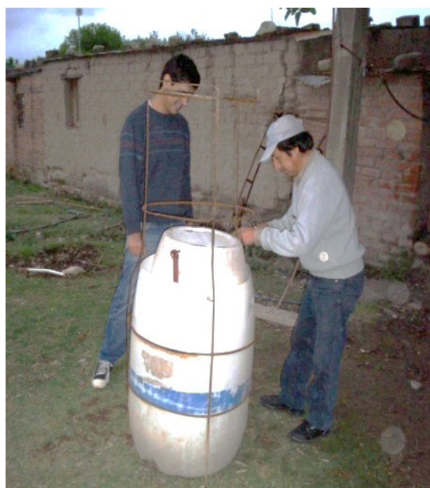
Figura N° 5. Construcción de estructura guía para el gasómetro.
