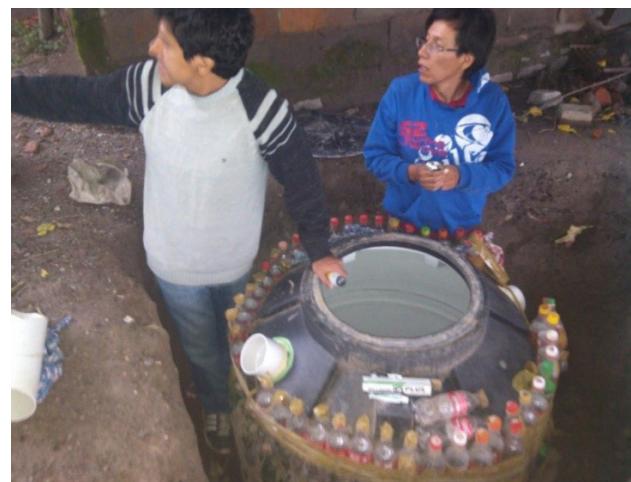
Figura Nº 2. Tanque con aislación de botellas PET.
