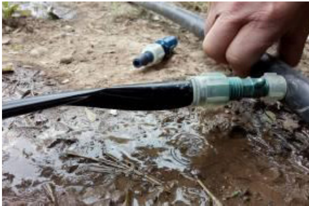
Foto N° 5: Instalación el sistema de riego por goteo Escuela N° 4258 Misión Chaqueña
